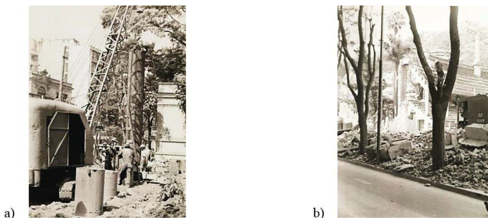
Figura 1. (a) Construção do Viaduto Eng. Noronha e (b) Alargamento da Rua Pinheiro Machado com a demolição da arquibancada do Clube de Futebol Fluminense
